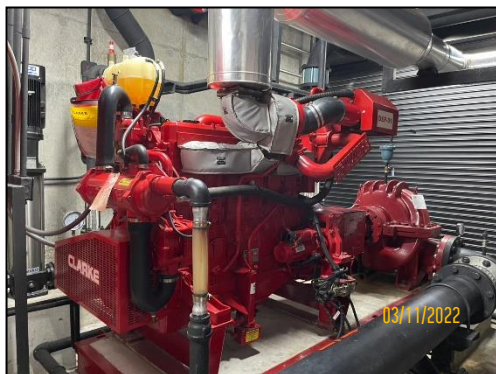
รูปที่ 2-63 เครื่องสูบน้ำดับเพลิง (Fire Pump) ชนิดเครื่องยนต์ดีเซล จำนวน 1 เครื่อง ทำงานร่วมกับ เครื่องสูบน้ำรักษาความดันในระบบท่อให้คงที่ (Jockey Pump) จำนวน 1 เครื่อง (1)
