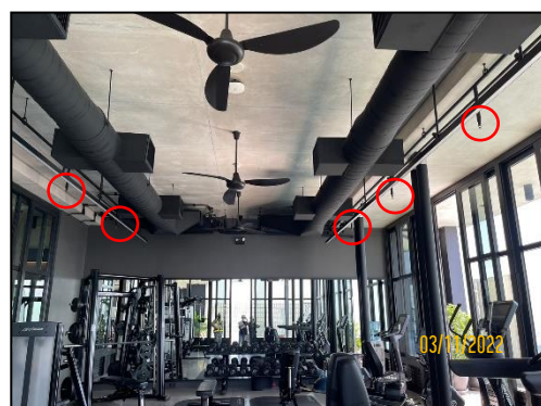
รูปที่ 2-66 ระบบหัวจ่ายน้ำดับเพลิงอัตโนมัติ (Sprinkler System) ทุกชั้นอาคาร (1)
