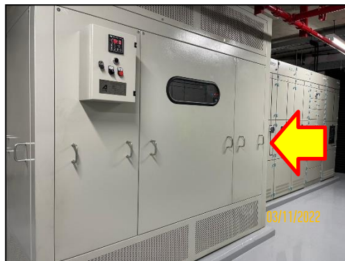
รูปที่ 2-46 หม้อแปลงชนิด Dry Type ขนาด 1,250 KVA จำนวน 2 ชุด สำหรับแปลงไฟฟ้าแรงสูง เพื่อจ่ายไปยัง Load ต่าง ๆ (1)
